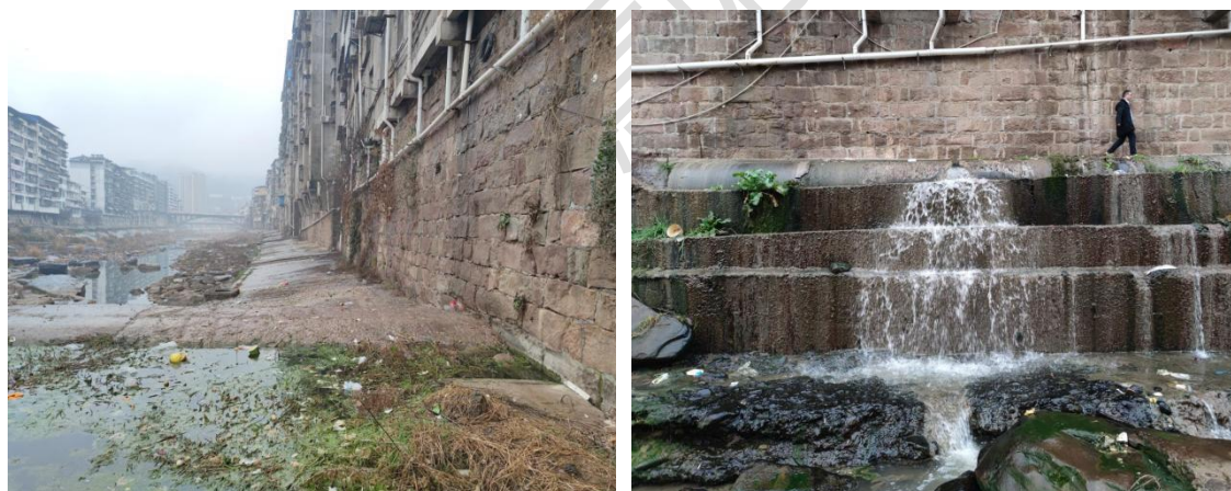
图 3-2 河道两侧污水管网现状
