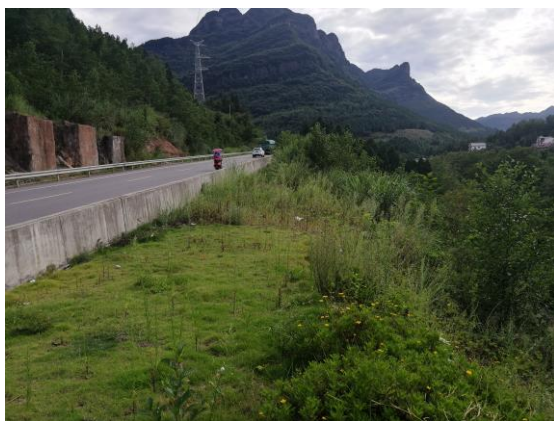
道路边坡绿化（2023.10）
