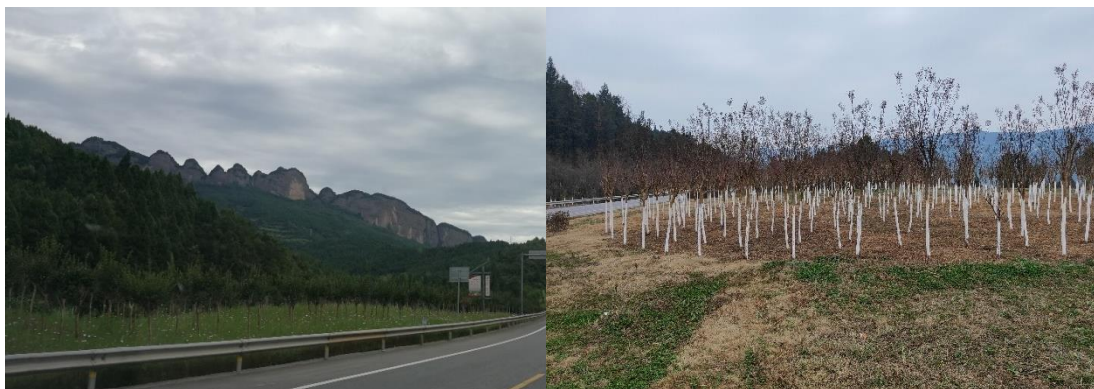
施工临时设施区绿化 (2023.10)
