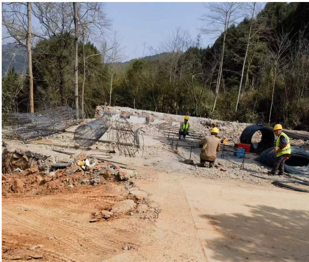
施工过程中实施照片
