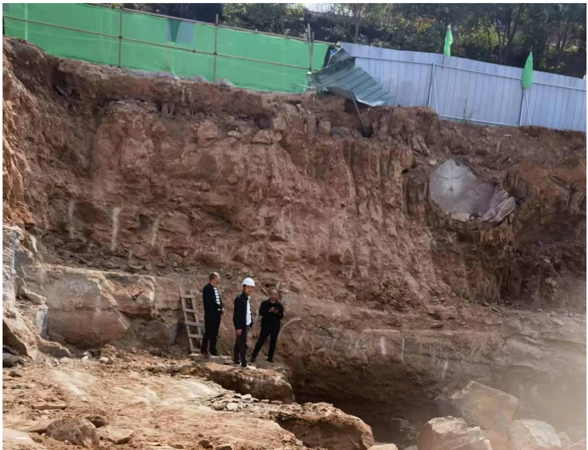
边坡施工现场照片
