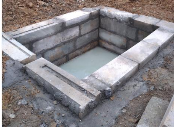
人工操作区废水沉淀池
