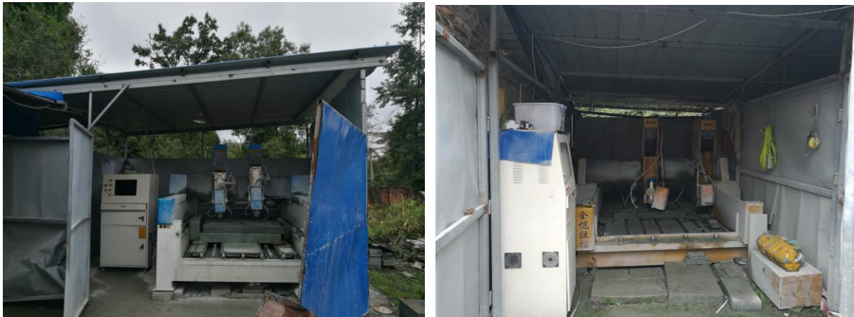
雕刻机喷水抑尘、厂房三面围闭
